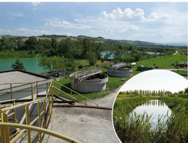
Depuratore e laghetto di fitodepurazione di Jesi
