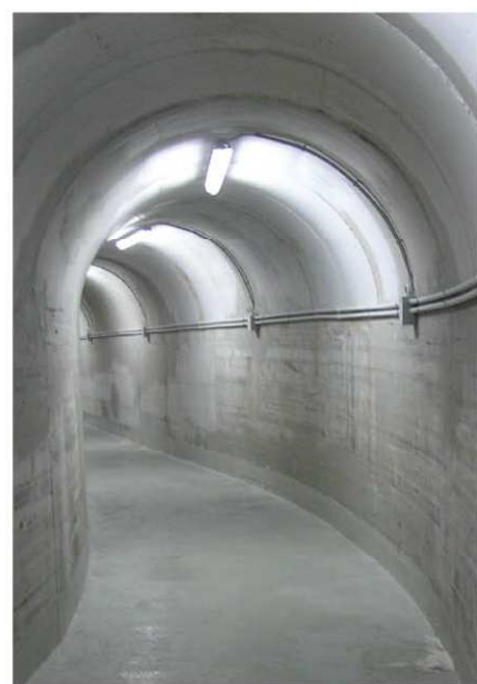
La nuova galleria d'ingresso
