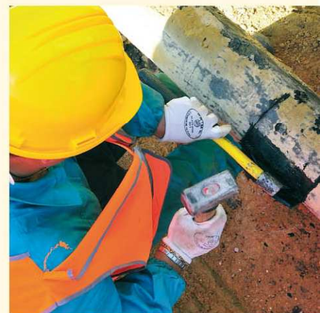
Intervento sulla rete gas
