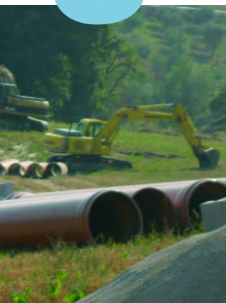
Lavori fognatura media Vallesina
