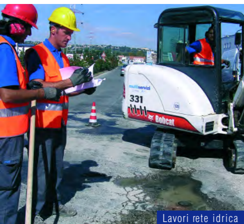
Lavori rete idrica
